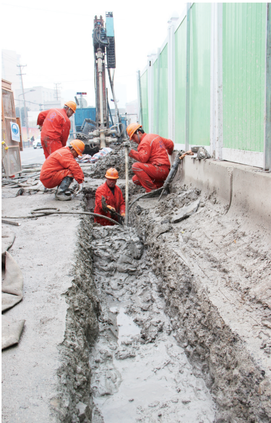
图为在中山北二路江浦路路口,施工人员正在实施出发井土体加固工程前期工序;工人冲洗地面,保持路面整洁。
