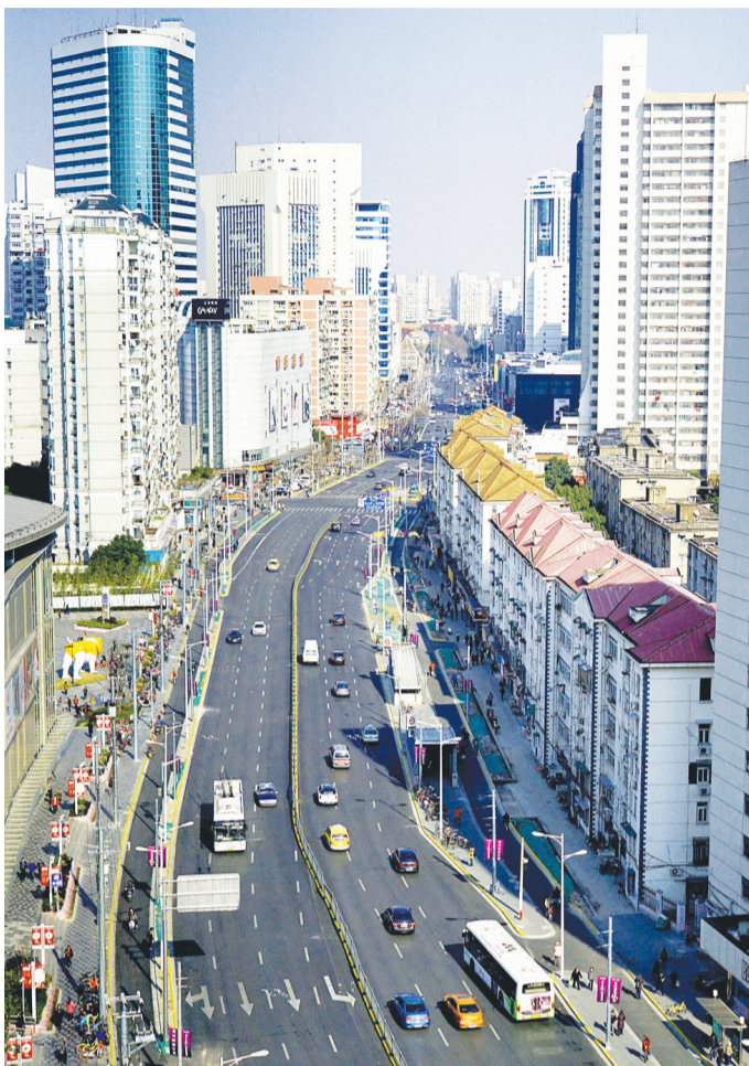
经过3个多月不封路、不改道、不扰民施工,控江路拓宽工程近日宣告完工,改建为六车道的控江路顺利通车。 ■种楠摄
