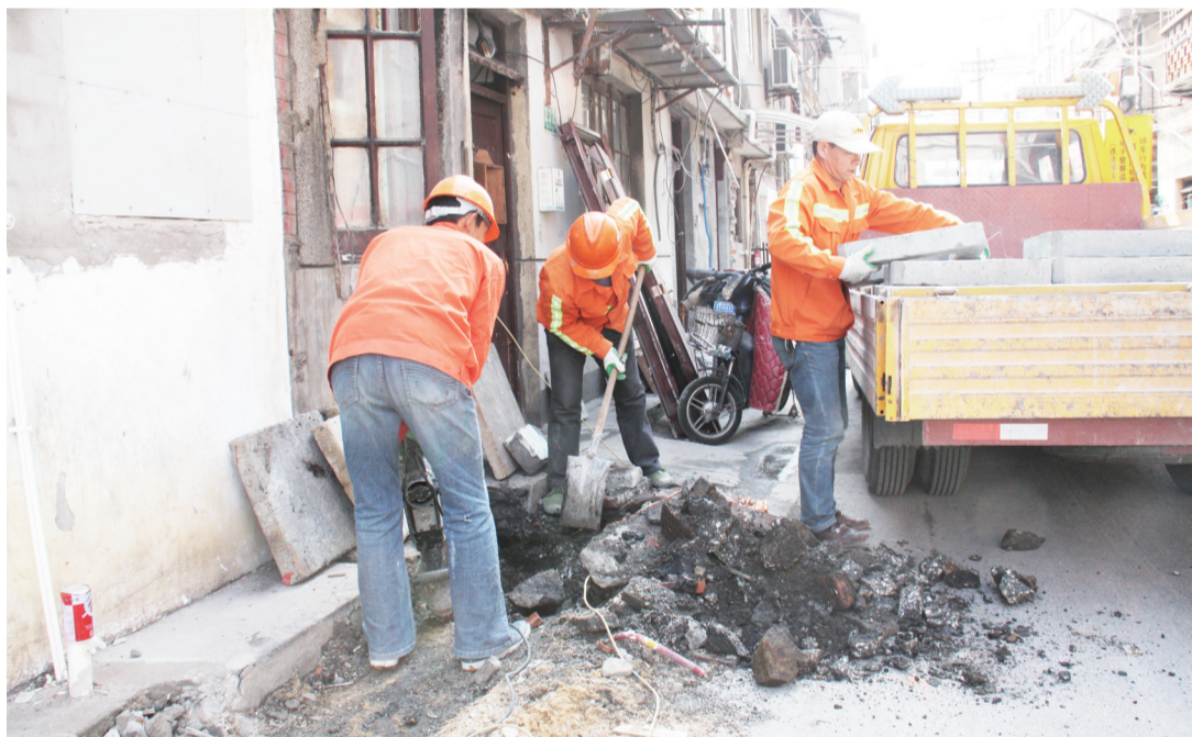
图为拆违工作人员正在对抗洼不平的路面进行清理并铺上平整的石板,为居民和车辆的安全通行提供保障。
