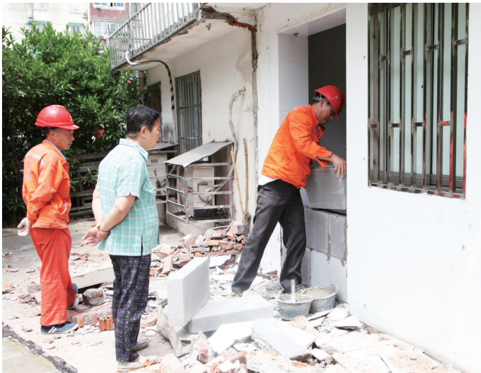
施工人员在住户的陪同下对破墙开门进行整改。
