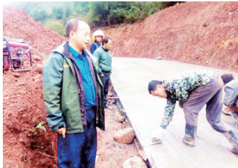
图为郭庆文(左一)在路面硬化施工现场。
