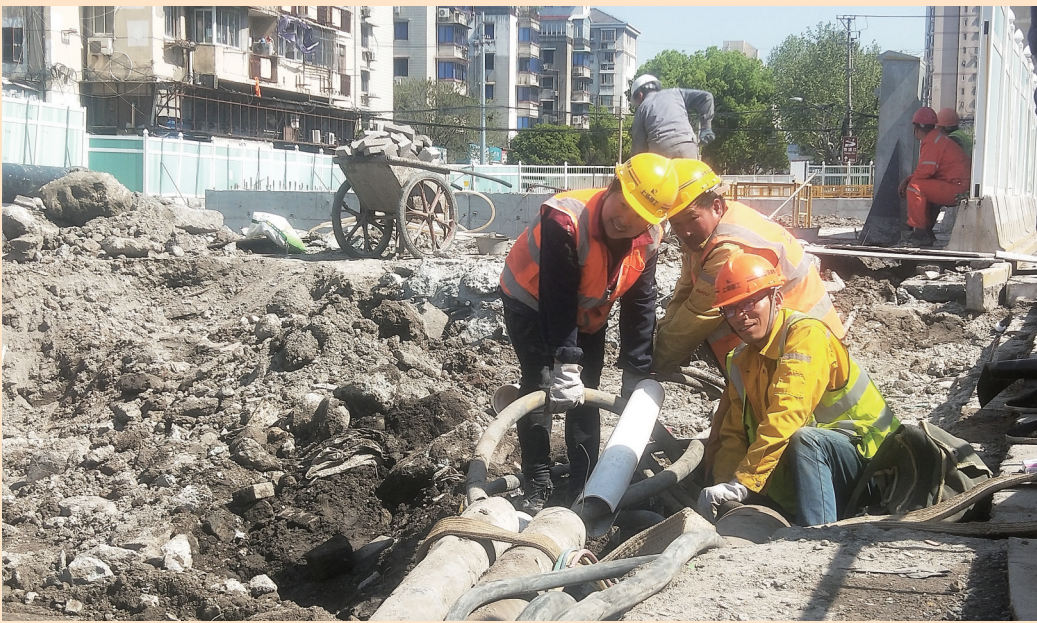
轨道交通18号线建设工程进展顺利,来日,位于平凉路江浦路的在建工地,工人们正紧张有序地进行电缆线排线铺管工作。
