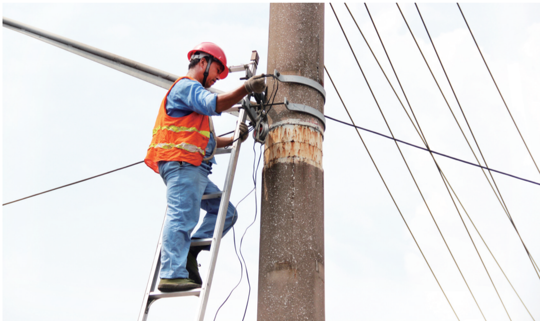
工人正在对尚未搬迁的架空线进行抬升、加固处理。
