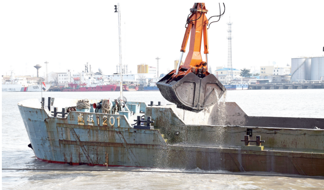
初春的上海,在远离闹市区的复兴岛北侧共青路486号,黄浦江畔清淤船“隆隆”的机器轰鸣声打破周边的寂静,船上作业的工人们安全帽、口罩、工作服等全副武装,迎着风浪抓紧作业,加快复兴岛临时码头改造工程建设进度。该工程为配合黄浦江公务码头杨浦大桥基地建设及杨浦滨江南段水域环境治理而实施,项目包括码头工程、配套工程两部分。(相关报道刊第2版) (记者 周琳)
