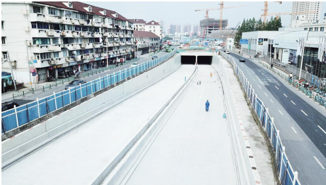
记者在现场看到,隆昌路下立交已完成土建结构施工,目前正在进行机电安装、绿化等附属工程施工。 ■记者 张维维 摄
