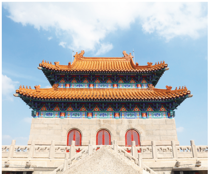
历经80多年沧桑的杨浦区图书馆,通过保护修缮,恢复了琉璃碧瓦、精致彩绘,以鲜明的中国古典建筑之美吸引大批参观者。(资料图) ■记者 朱奕楠 摄
