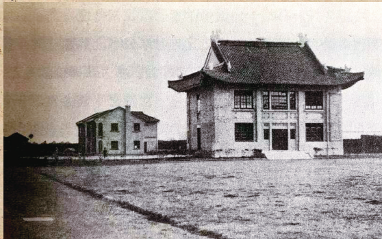
1921年建成的奕柱堂(今复旦大学校史馆)
