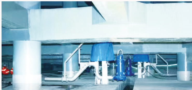
工程内部结构照片
