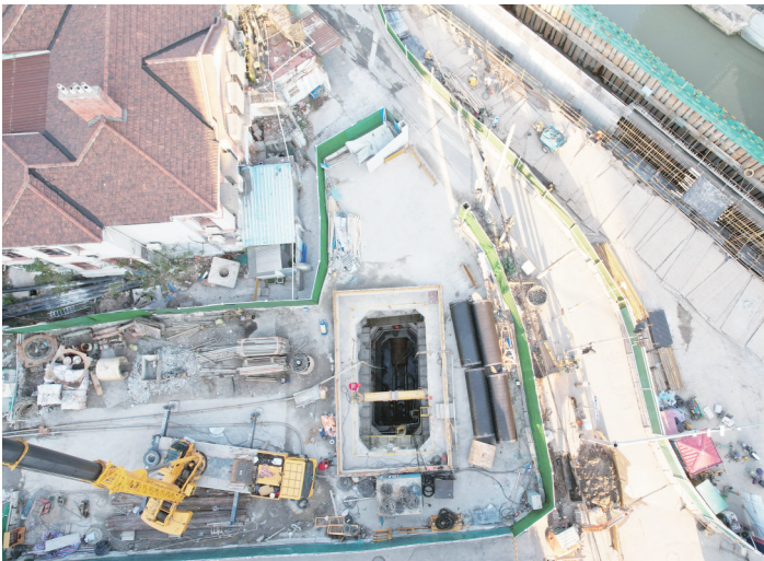
工程完成关键节点:上水管顶管穿越杨树浦港。 ■图片由区建管委提供
