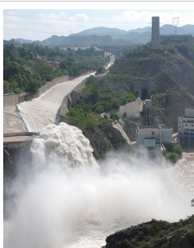
近期受强降雨影响,黄河流域处于主汛期,刘家峡水电厂按照调度命令,7月23日18时29分,溢洪道提闸泄水,加大下泄流量,同时5台水电机组进入大发电状态,确保黄河流域安全度汛。 ■新华社
