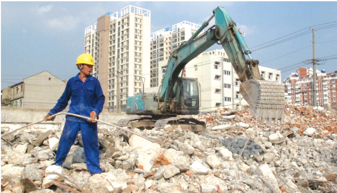
图为2010年12月启动的大桥街道109街坊地块,52产已签约50产,签约率为96.15%。截至目前,其中的2.5万平方米原上海铝材厂建筑已拆除99%,计划于本月底全部完成。
