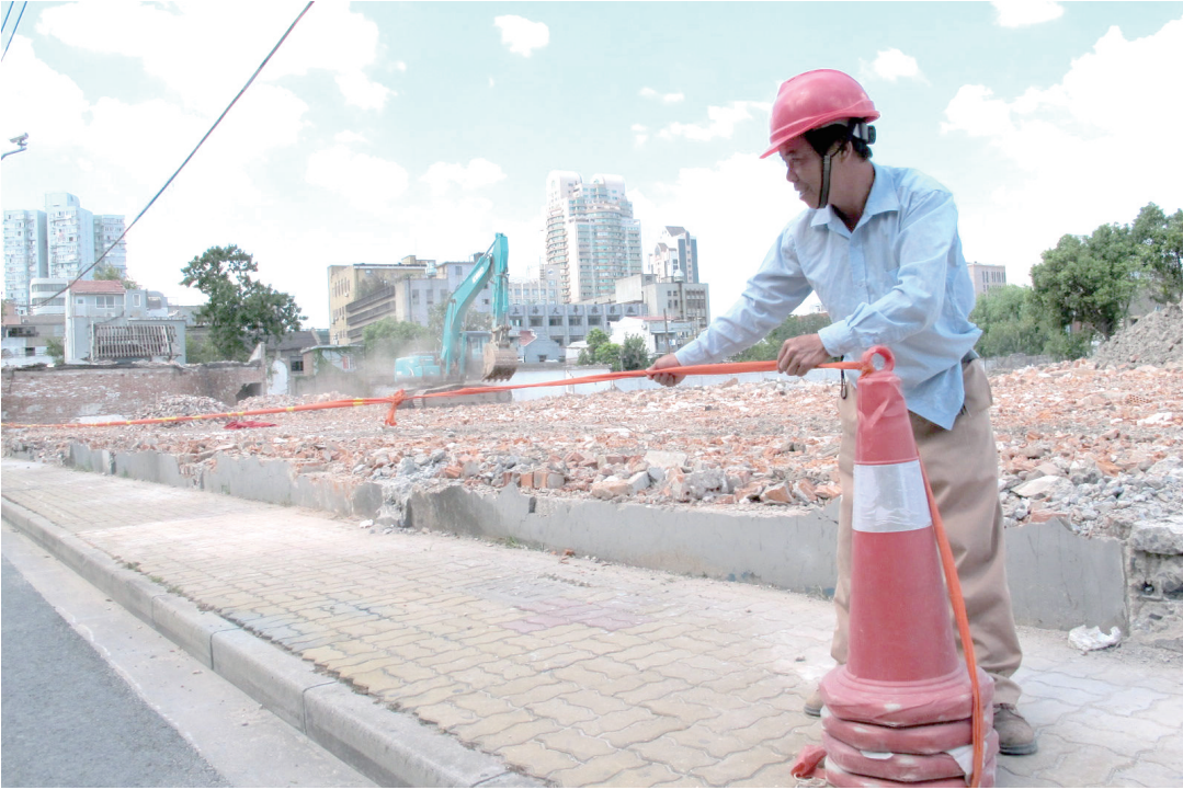
9月2日下午,大桥街道109街坊旧改征收基地上,原上海铝材厂2.5万平方米建筑已全部拆除完毕,建设工人在最后推倒的眉州路围墙外拉起警戒线和安全网,等待新的建设项目施工方入驻。
