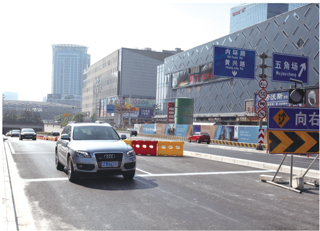
经过一段时间的整修,五角场下立交(南向北)方向通道于近期重新开通,这将有助于缓解该地区地面交通压力,为市民到达创智天地、区人才广场、新江湾城等地提供了便利。
