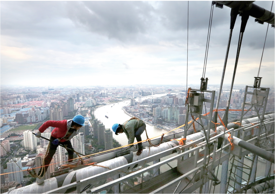
10月18日,工人在“上海中心”大厦79层安装玻璃幕墙。“上海中心”系世界首次在超高层建筑中采用“内外”双层方式安装14万平方米柔性幕墙。安装完成后,不仅为大厦提供外保护和温度缓冲区,还将形成24个空中花园。目前,“上海中心”大厦玻璃幕墙安装已完成大半。 ■新华社
