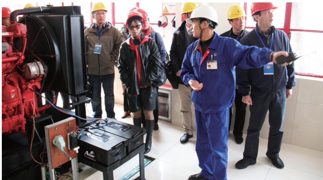
11月27日,为期两天的2013年政协委员集中视察启动,组织委员了解产业发展、消防安全、旧区改造、机构养老情况。图为昨天下午,委员在中国石化上海石油储运分公司杨浦油库视察消防安全工作情况。■记者 应沈漪 摄
