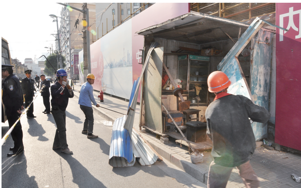
11月18日,平凉路街道拆除龙江路近怀德路人行道上违规占道经营的牛奶棚。
