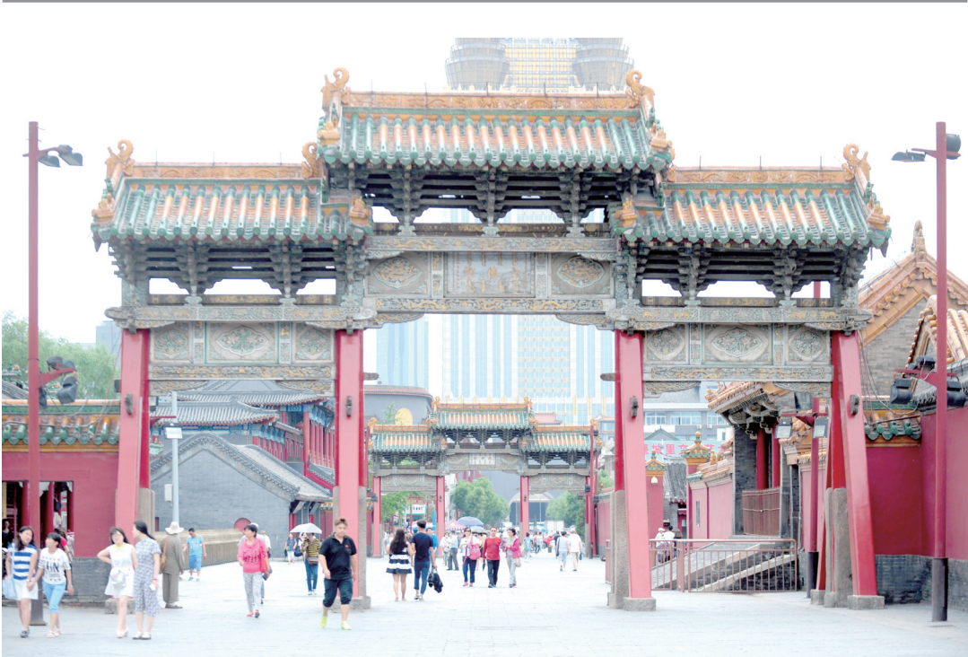
日前,沈阳故宫今年首次修缮工程进入尾声,文德坊、武功坊等工程已经完毕。据了解,本次修缮工程历时近三个月,对沈阳故宫的文德坊、武功坊及东大门和东朝房等按照修旧如旧的原则进行油饰修缮。 ■新华社 张文魁 摄
