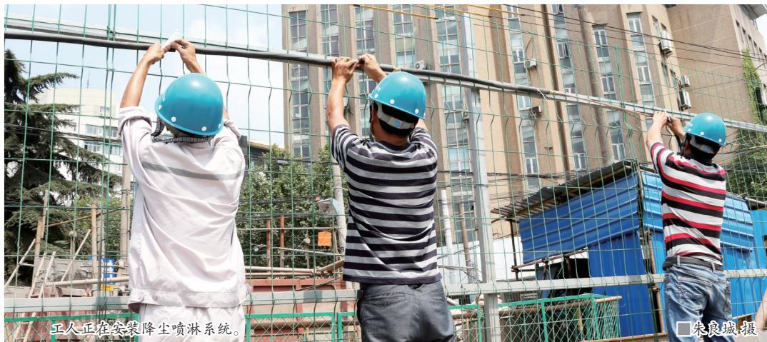
工人正在安装降尘喷淋系统。
