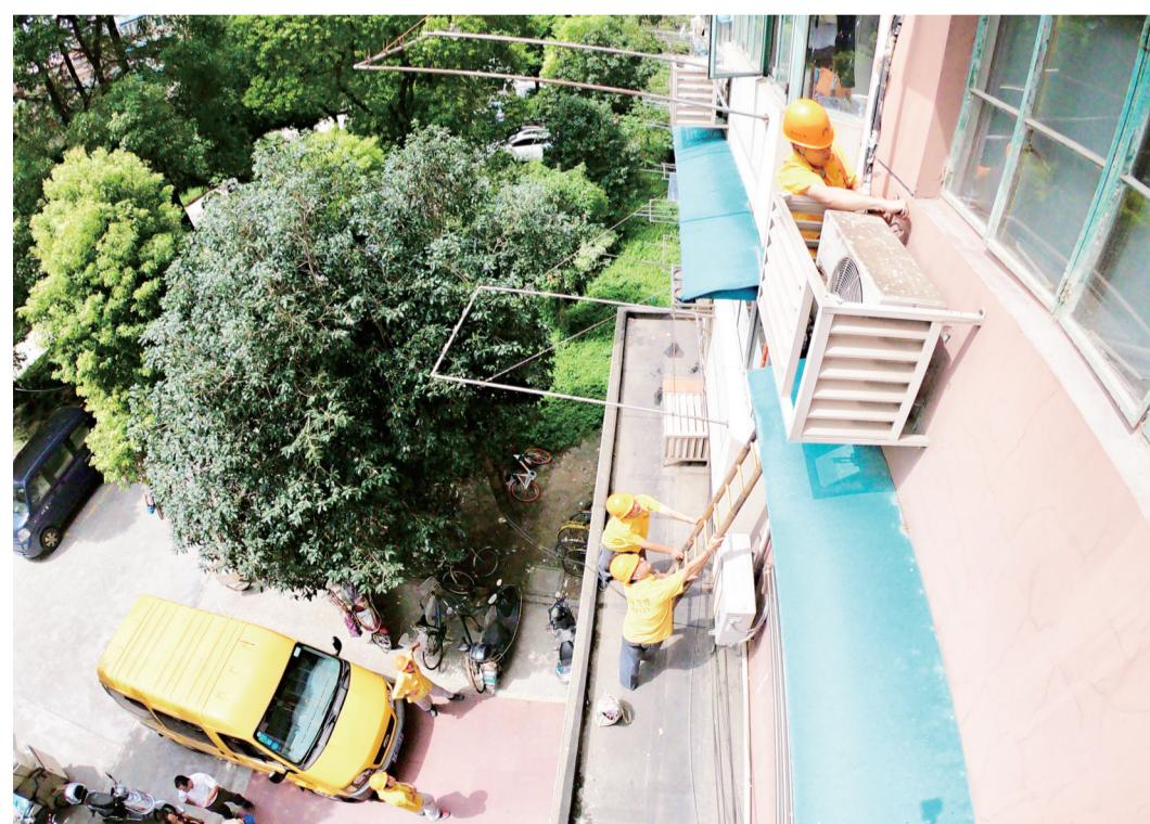
延吉物业公司近期对辖区内19幢高楼,15个街坊130万平方米老旧小区进行了安全大排查,尤其对多层住宅楼的三大件:雨篷、晾衣架、空调架,进行了仔细检查,并加固。图为工作人员昨日在延吉六村15号楼加固空调架。 ■种楠 摄
