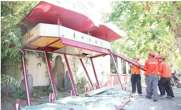
施工工人正在拆除位于殷行路850弄的占道亭棚。
