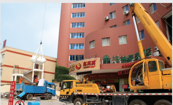
6月24日至25日,江浦路街道拆除长阳路999号格林豪泰宾馆顶楼近1000平方米的违法搭建。 ■杨晓梅 摄
