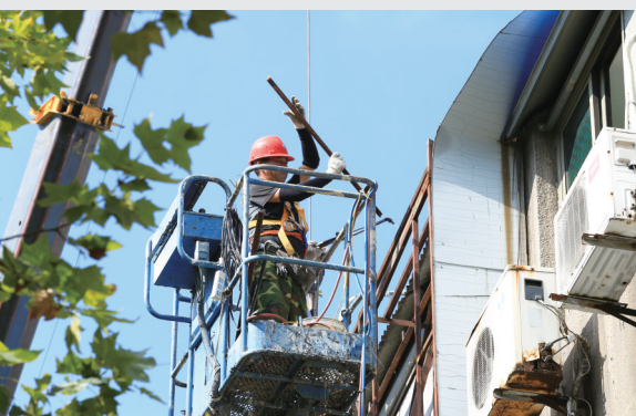
8月22日,殷行街道拆除包头路一家临街店铺存在安全隐患的店招。 ■王修远 摄
