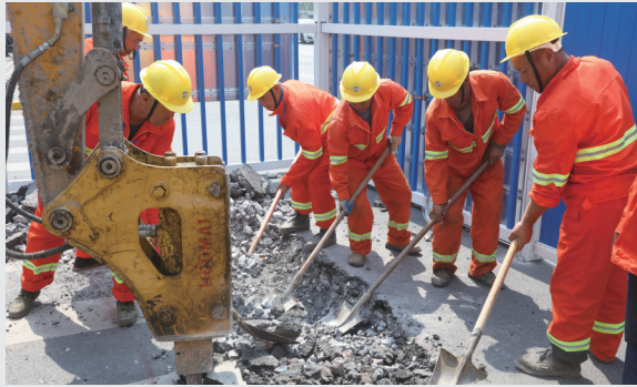
4月27日,源泉路(控江路-周家嘴路)架空线入地工程开始电力排管施工。 ■朱良城 摄
