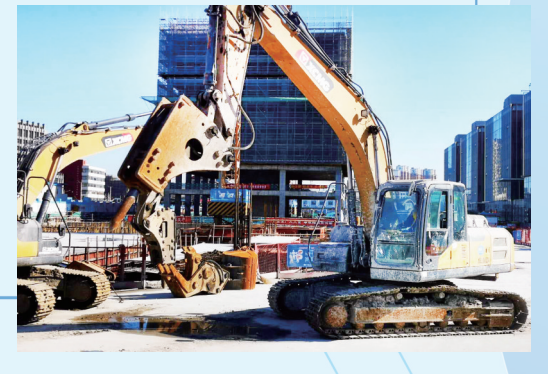
2月18日,138街坊商办综合体项目复工。图片由区建管委提供
