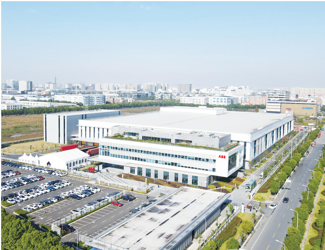
12月2日空中俯瞰位于上海浦东新区的ABB机器人超级工厂(无人机照片)。
