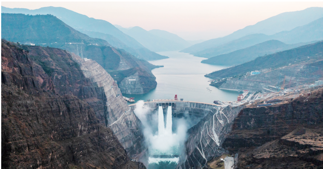
白鹤滩水电站位于四川省宁南县和云南省巧家县交界的金沙江干流河段上,总装机容量1600万千瓦,是我国实施“西电东送”的国家重大工程,共安装16台我国自主研发的全球单机容量最大功率百万千瓦水轮发电机组。
