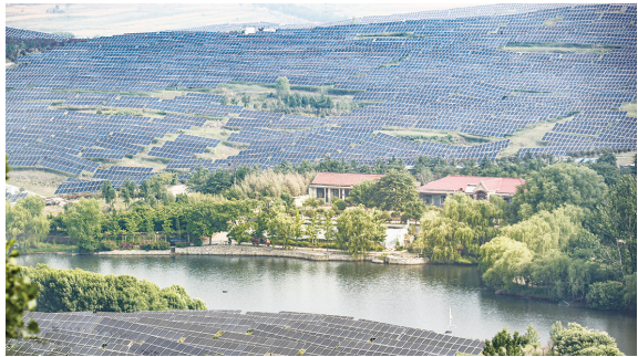
山东省日照市东港区三庄镇在丘陵薄地上占地4700亩,实施90MW集中式农光互补扶贫电站项目。采取光伏发电+农业+观光科普“三位一体”模式,实现经济效益、社会效益、生态效益“三丰收”。
