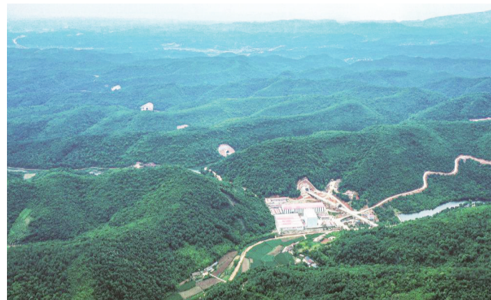
5月21日，位于湖北当阳的沪渝蓉高铁石门1号隧道顺利贯通。至此，沪渝蓉高铁武宜段全线25座隧道全部贯通。沪渝蓉高铁是国家“八纵八横”高铁骨干通道之一，线路总长约2100公里，全线设计时速350公里。图为沪渝蓉高铁武宜段贯通的隧道群(无人机照片)。
