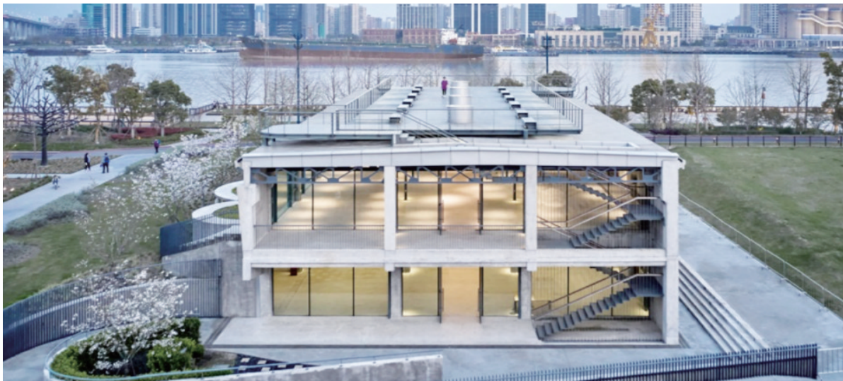
作为中国近代工业发祥地,杨浦滨江留下众多工业遗存和极其珍贵的精神价值,明华糖仓始建于1923年,占地面积约800平方米的临江仓库,系现代风格的无梁楼盖结构。通过对其“重现风貌、重塑功能、重赋价值”的修缮改造,百年工业遗存实现“再利用”。(资料图)
