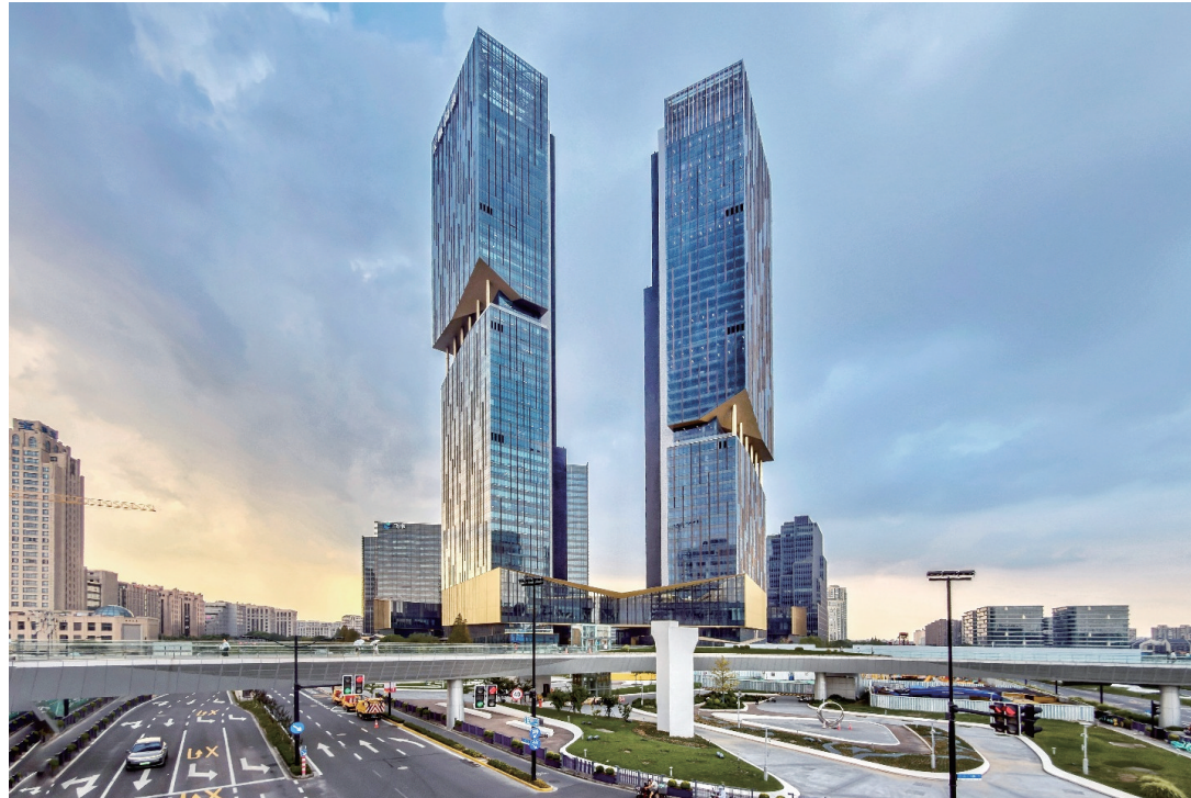
核心筒及电梯厅外置,在全球500座最高建筑中仅占3%,成本和难度成倍增加,却让空间规划更灵活,整层楼面得以完全打通,形成无遮挡的完整大空间。资料图
