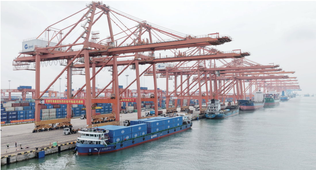
这是9月16日在广西钦州市拍摄的北部湾港钦州港区。9月16日,新中国成立以来第一条国家层面统筹建设的通江达海运河工程——平陆运河建成通航,开辟西南出海新通道。
